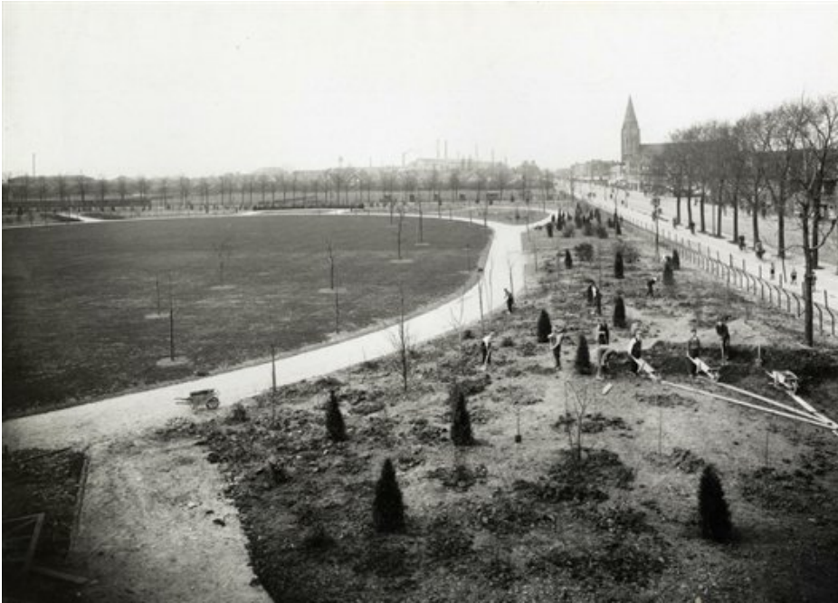
Figuur 26 De aanleg van de speelweide met rechts de Amsterdamsestraatweg
