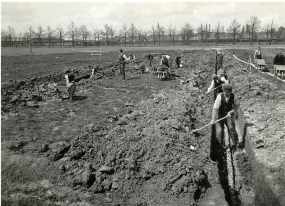
Figuur 27 Het graven van een drainagesleuf door werkloze jongeren
